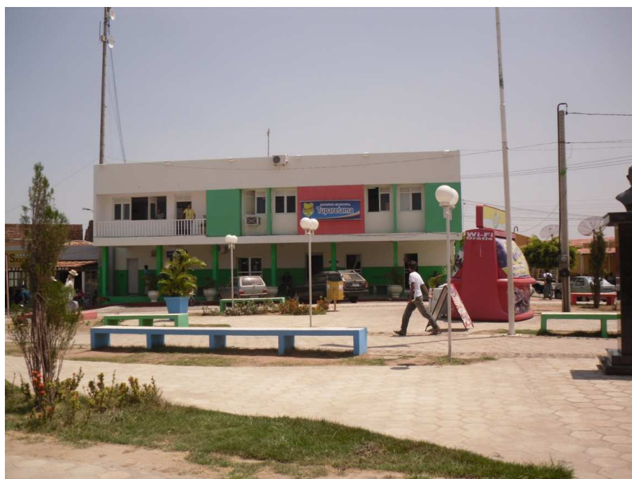
Figura 2 – Sede da Prefeitura de Tuparetama – PE Fonte: ITEP/ UGRS, 2013.
