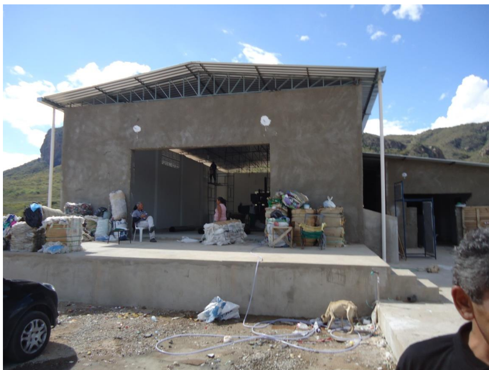
Figura 3 – Cooperativa de catadores em Serra Talhada. Fonte: ITEP/ UGPRS, 2013.
