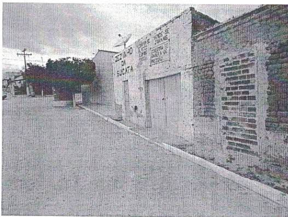
Figura 7 – Depósito de Zezinho – Itapetim/ PE.
