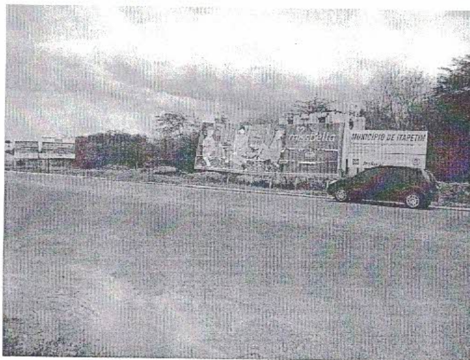
Figura 1 – Estrada de acesso ao Município de Itapetim.
