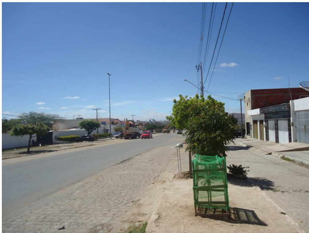
Figura 1 – Via de acesso dentro do Município de Custódia.
