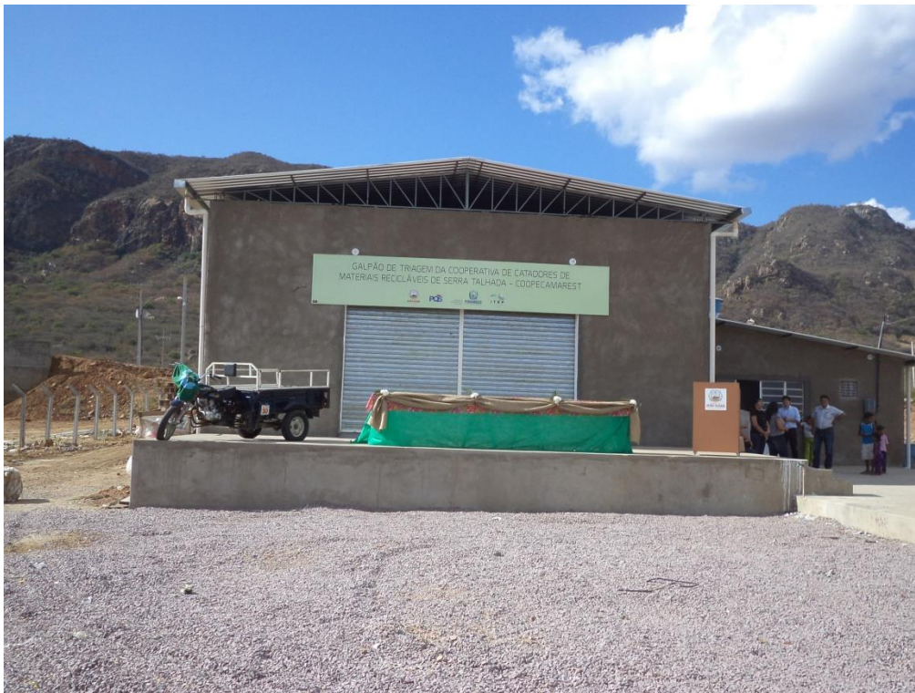
Figura 29 – Galpão da Coopecamarest em Serra Talhada.
